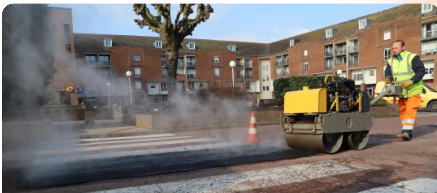
Travaux de voirie Boulevard Leclerc
