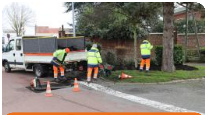
Travaux de voirie et aménagement des espaces verts
