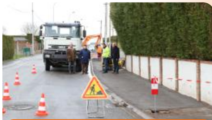
Réparation des trottoirs Boulevard Castelnau
