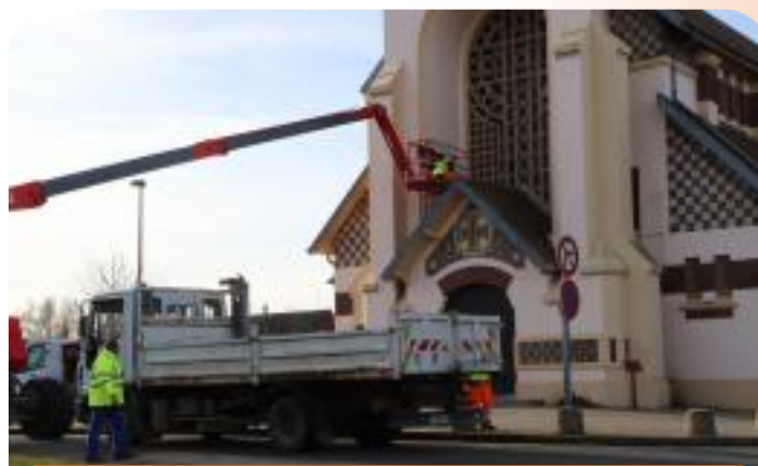
Travaux d'étanchéité de la salle Marguerite
