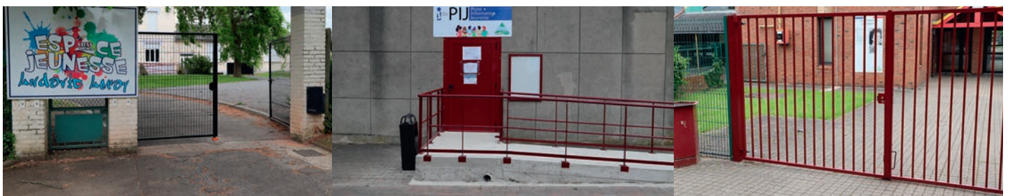
Installation d'une grille pour sécuriser l'Espace Jeunesse « Ludovic LEROY » ; réalisation d'un accès « Personne à Mobilité Réduite » au Point Information Jeunesse ; et installation de grilles à ouverture automatique aux entrées des écoles
